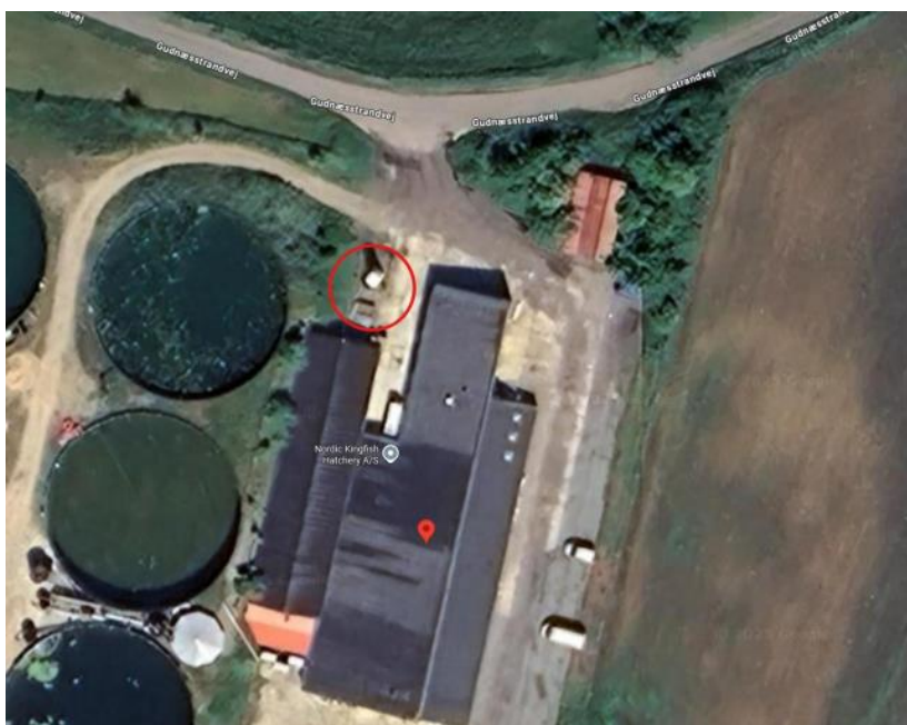
Fig. 5. Luftfoto indsendt af ansøger hvorpå placeringen af den eksisterende (og ansøgte) oxygentank er indtegnet med rød cirkel.
