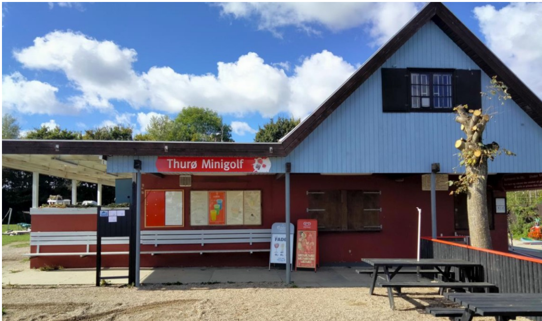
Foto af eksisterende bygning med overdækning set fra øst.
