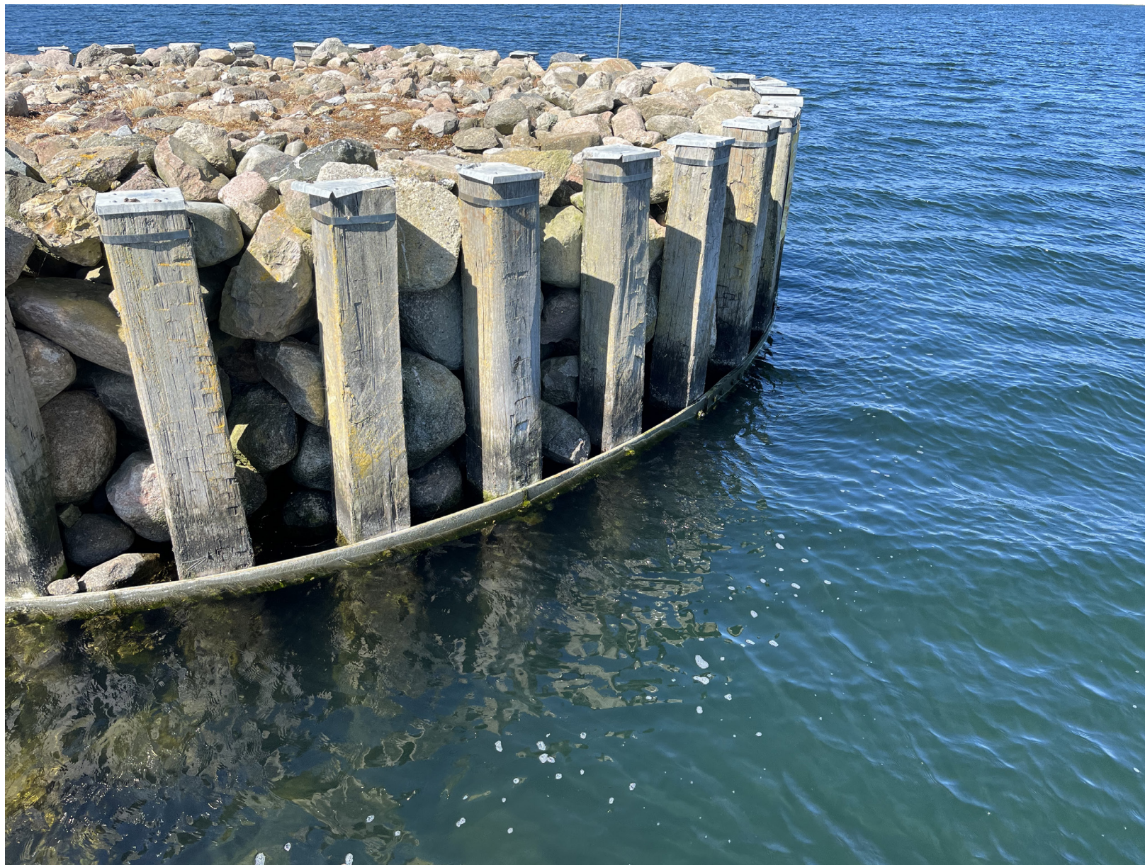
Figur nr. 20 viser eksempel på molehoved med pæle
