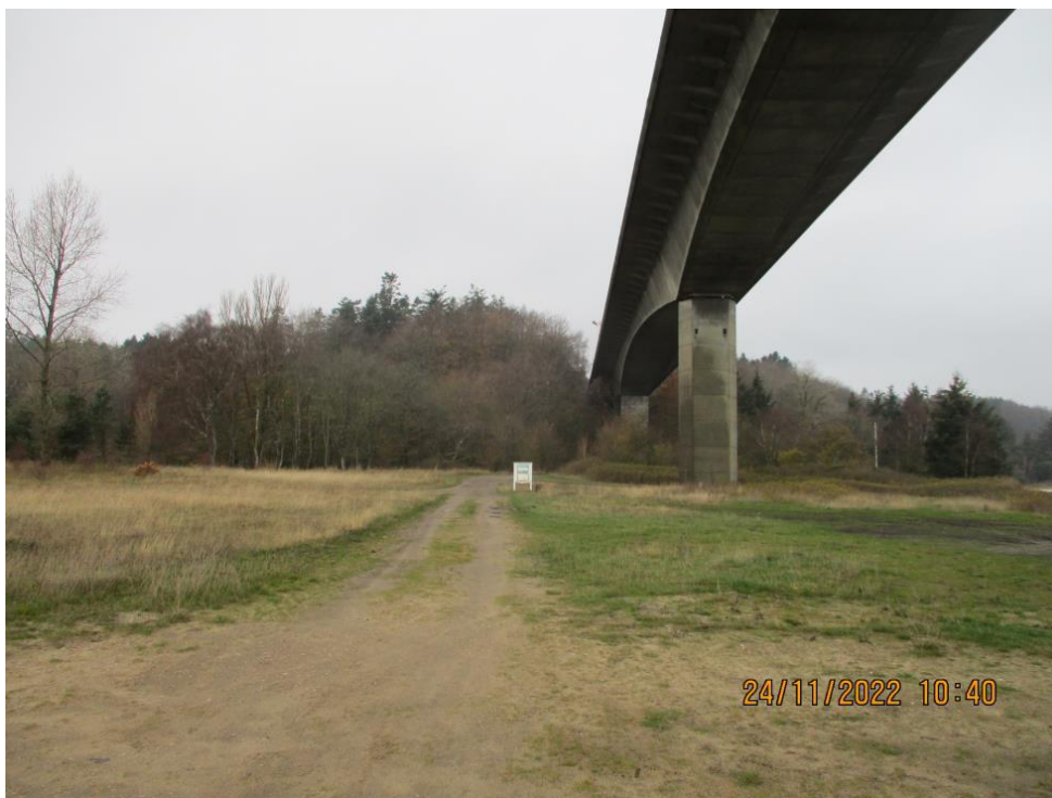
Figur 4 Billede af ønskede anstillingsplads og adgangsvej på Morsøsiden
