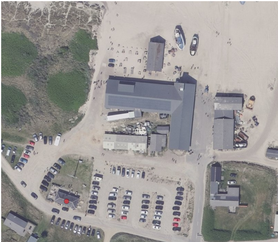
Kiosken markeret med rød prik
