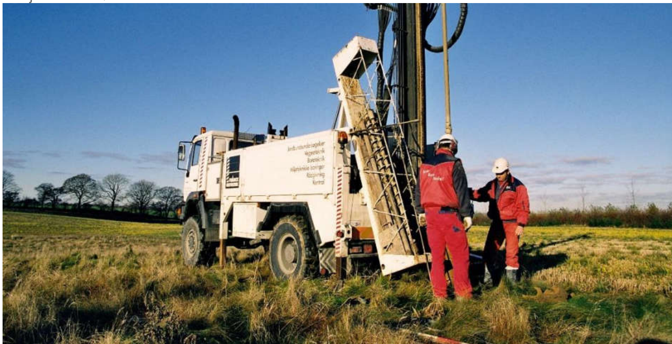
Figur 6 - Eksempel på en geoteknisk borerig.
