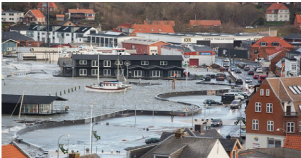
Højvandsmur i Lemvig
