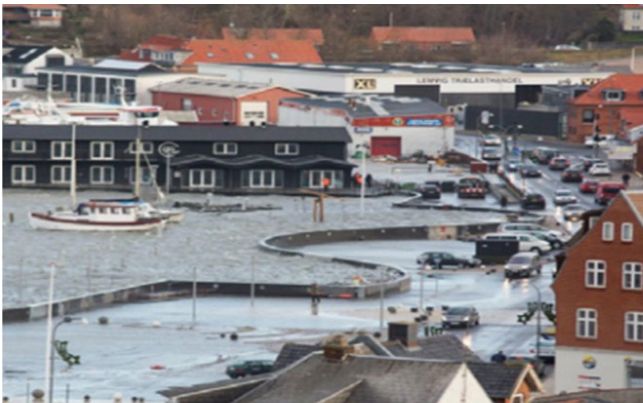
Højvandsmur i Lemvig
