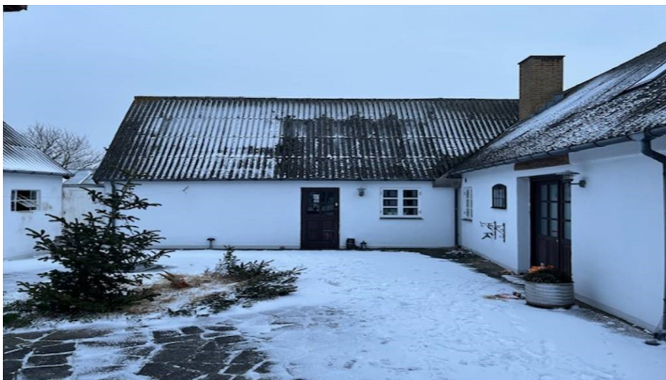
Figur 2, foto fra ansøgning af taget, hvor vinduerne opsættes. Vinduerne placeres, hvor sneen er smeltet.
