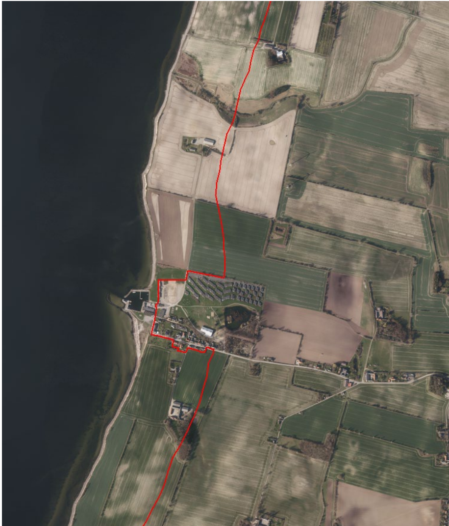
Figur 2. Luftfoto 2017 viser Dageløkke Havn midt i billedet mod vest. Strandbeskyttelseslinjen er markeret med rød.
