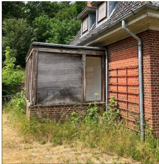
Underliggende belægning afspejles i bevoksningens struktur
