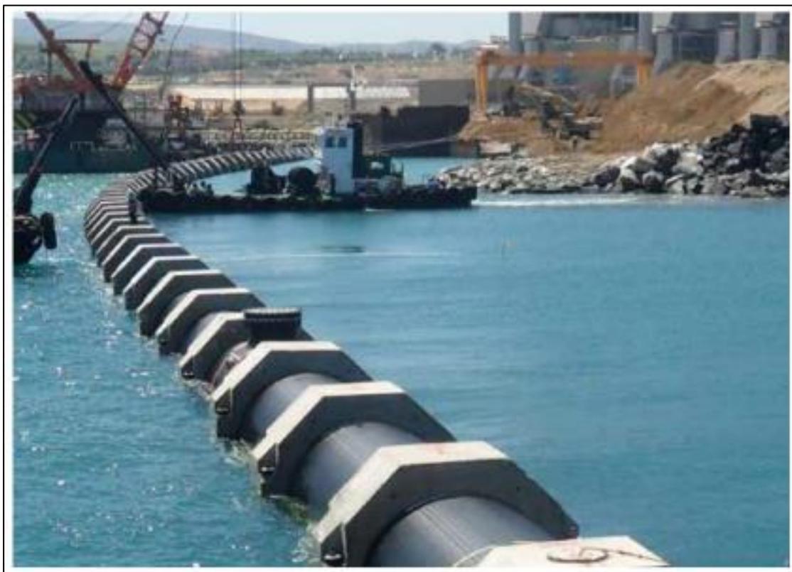
Figur 2-2 Eksempel på stor PEH-ledning med monterede ballastklodser. Kilde: Pipelife.com
