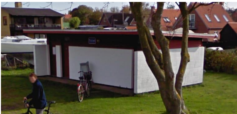
Fig. 8. Udklip fra Google Streetview. På figuren ses et billede af den nuværende toiletbygning nordvest-vendte facade.
