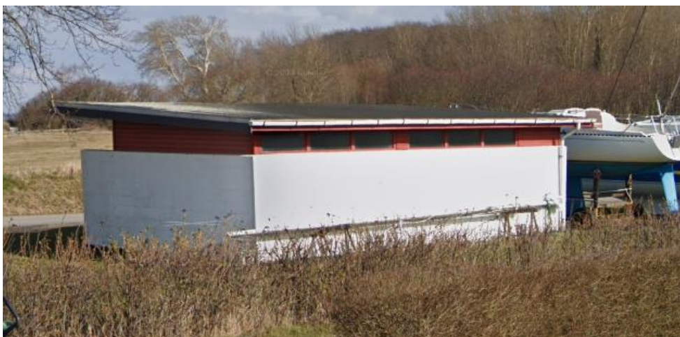
Fig. 10. Udklip fra Google Streetview. På figuren ses et billede af den nuværende toiletbygning sydvest-vendte facade.
