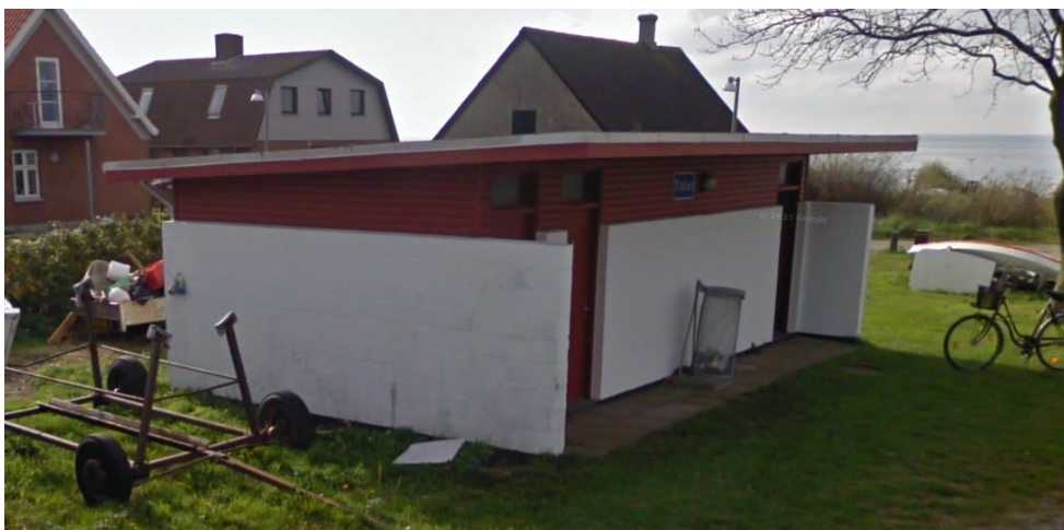
Fig. 9. Udklip fra Google Streetview. På figuren ses et billede af den nuværende toiletbygning nordøst-vendte facade.
