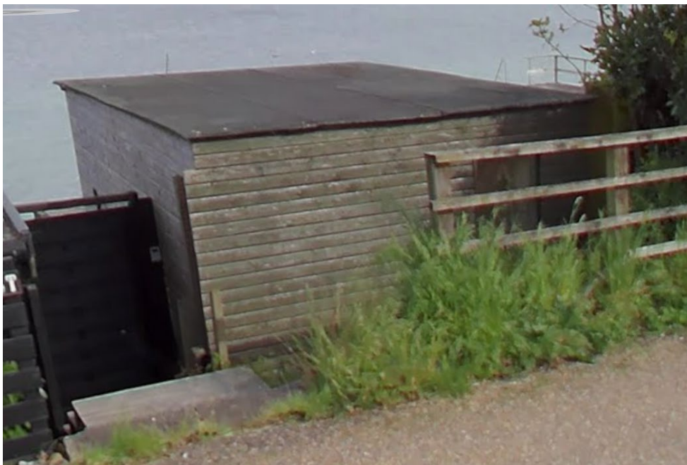
Fig. 4. Google Street View 2025, viser nuværende trappe nedgang til strandhuset.
