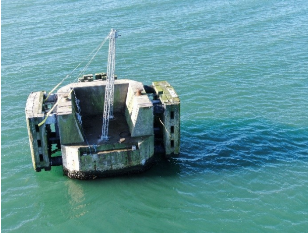
Fig. 2. Foto af kabeltårn på fundament fra oliepier.
