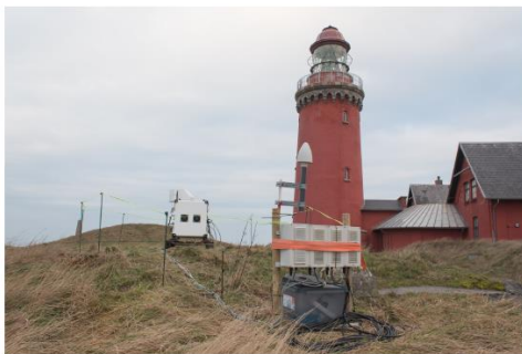
Én lidar (fjernmåler af vind) ved Bovbjerg Fyr med power supply og kommunikationsudstyr. Det påtænkes at blive installeret to lidars på denne position.
