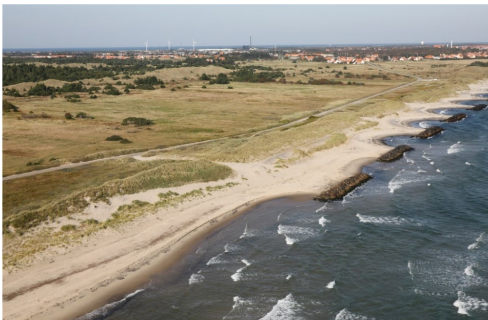
Bølgebrydere ved Skagen. Bemærk læsideerosionen og den karakteristiske guirlandeformede strand
