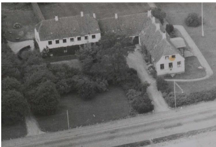
Oprindeligt stiforløb omkring ejendommen (stien til højre i billedet retableres)
