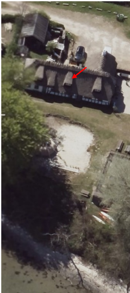
Fig. 3. Skråfoto fra 2023, der viser bygningens nordside der ligger ud mod kysten. Den røde pil markerer den kvist der ønskes udvidet.
