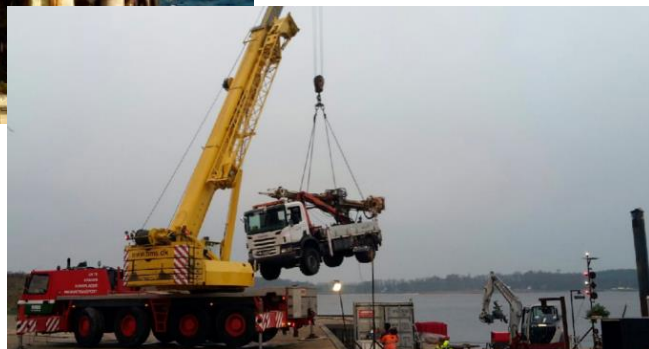
FIGUR 2-1 MONTERING AF FORERØR (HEROVER) OG LØFT AF BORERIG FRA KAJ TIL FLÅDE (TH)
