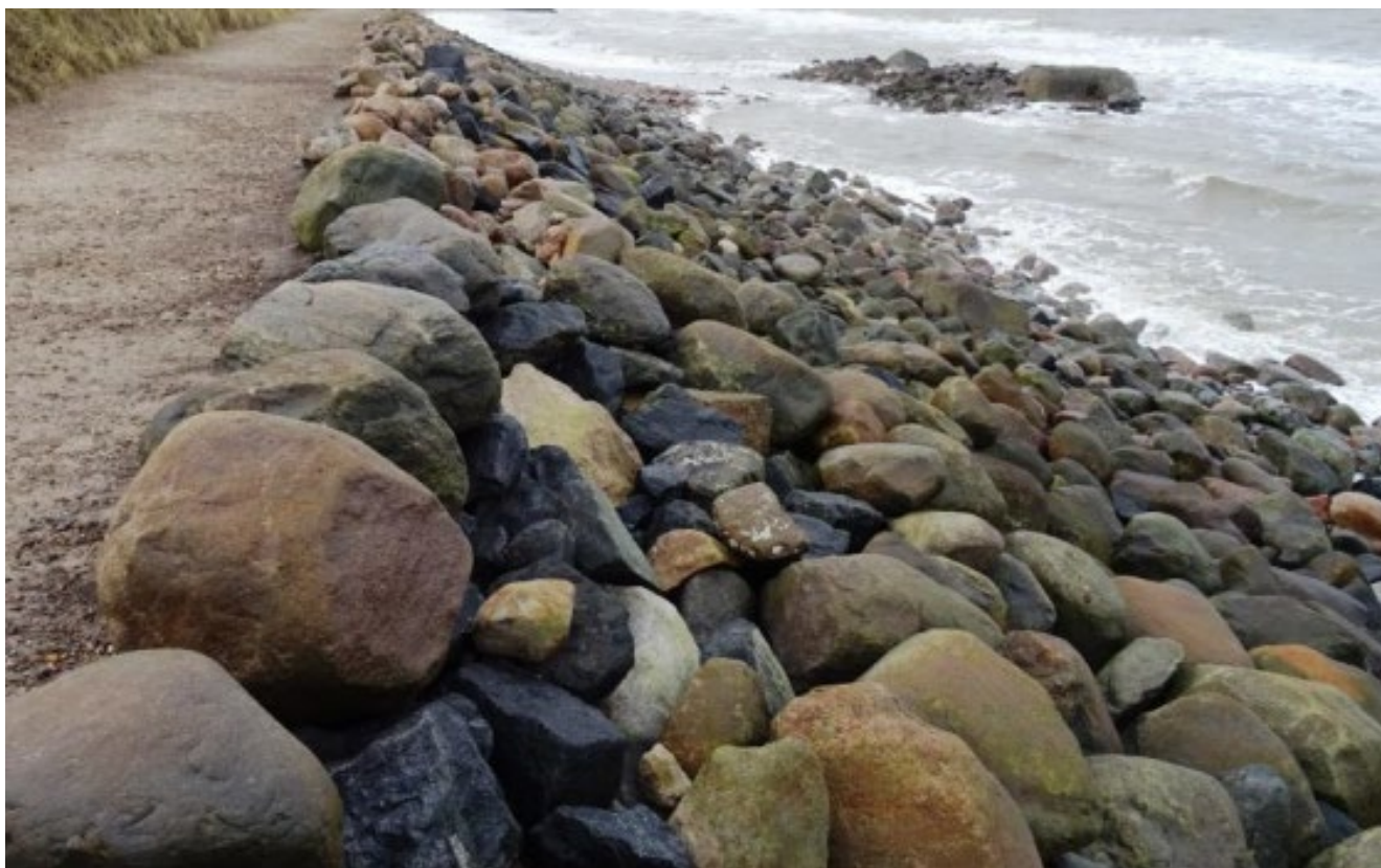
Etableret skråningsbeskyttelse af sten
