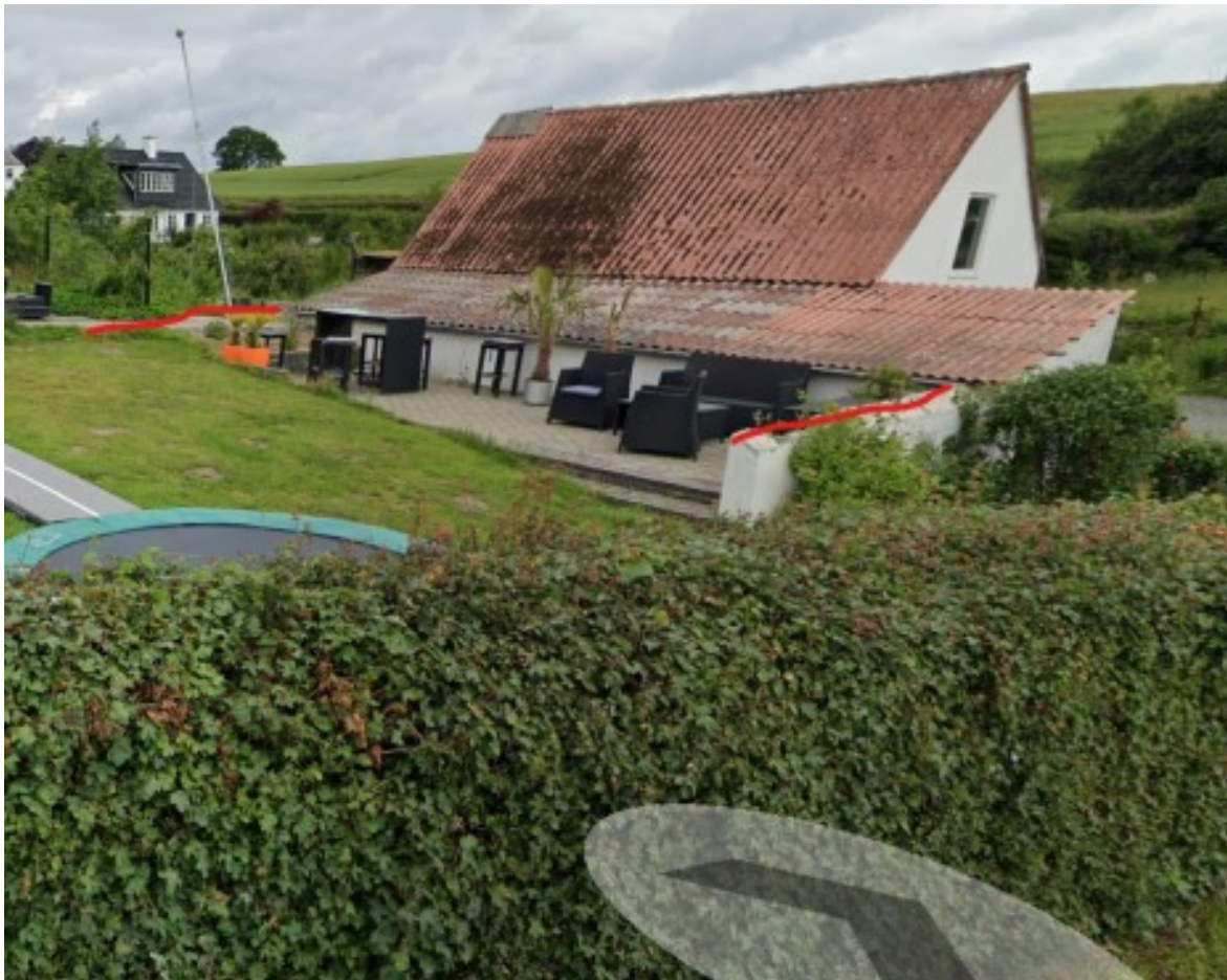
Foto fra ansøgningsmaterialet viser eksisterende terrasse. Den søges hævet, så den flugter med overkanten af den hvide mur, der ses i forgrunden. Det ses i baggrunden af billedet, at terrassen i dag ligger delvist under det omkringliggende terræn.
