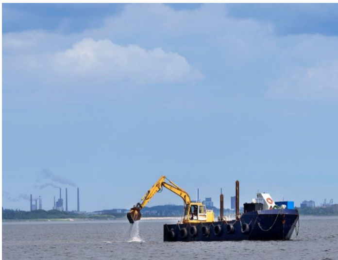
Eksempel på pram med gravko til udlægning af sten
