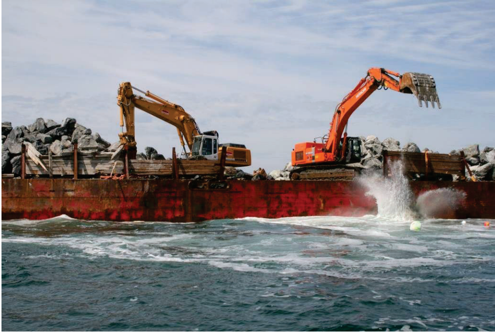
Figur 4.3: Gravemaskiner på flåden placerer sten til stenrev.
