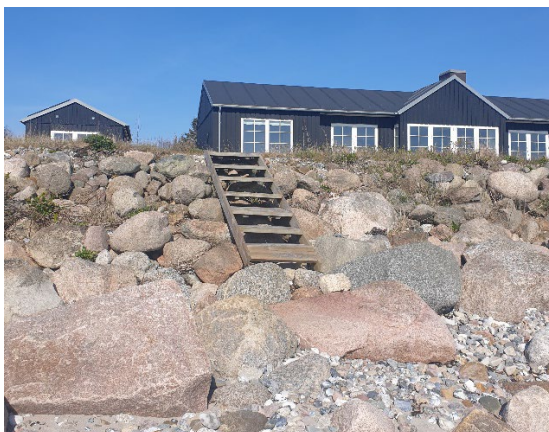
Figur 7. Skråningssikring ved hofdegruppe 6.
