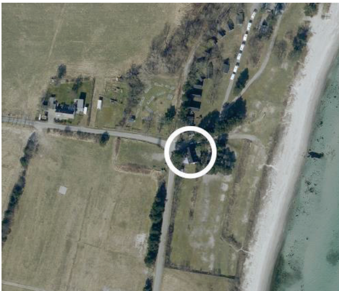
Fig.3. Tilsendt fra ansøger. Placeringen af servicebygningen er markeret med en hvid cirkel.
