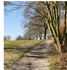
Eksisterende trappe der udskiftes
