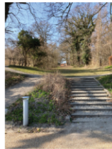
Eksisterende trappe i granit TR1
