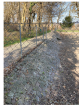
Eksisterende stensætning ved tennisbane - repareres
