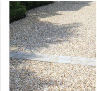
Eksempel på tværgående belægningsbånd.
