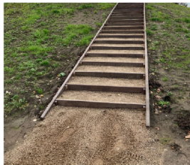
Eksempel på ny trappe med egesveller som trinfor-kanter og vanger
