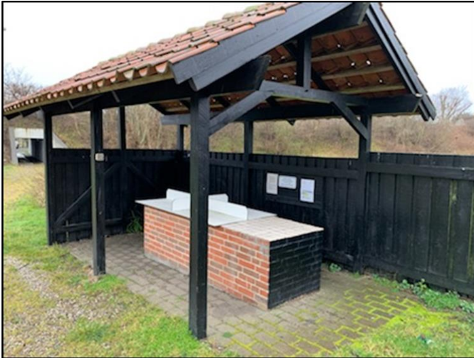
Foto af den eksisterende bygning. Indsat fra ansøgningen.
