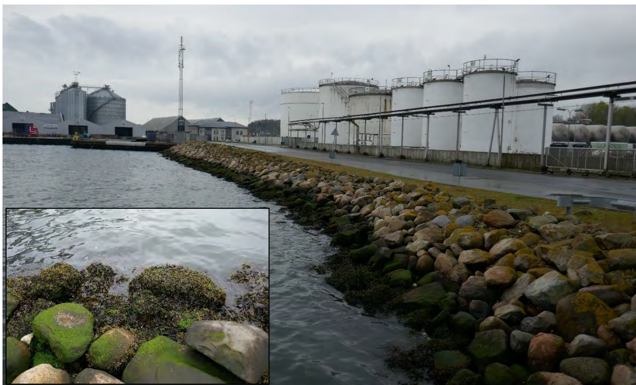
Figur 2-2 Skråningsbeskyttelsen ved Kaj 23 med udgik fra den eksisterende pier mod Møllebugtvej (24.04.2023). Figuren viser desuden, at der på stenene i tidevandszonen er bl.a. blæretang ( Fucus vesiculosus ), savtang ( Fucus serratus ) og diverse tarmrørhinder ( Enteromorpha sp. ).
