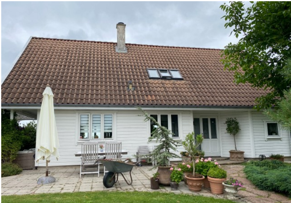
Foto af sydfacade. Eksisterende forhold.
