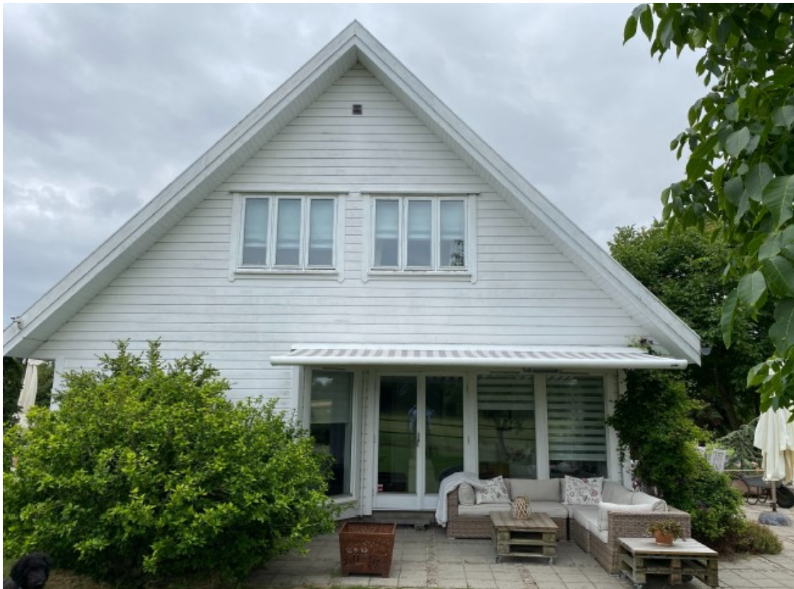
Foto af eksisterende facade mod vest.
