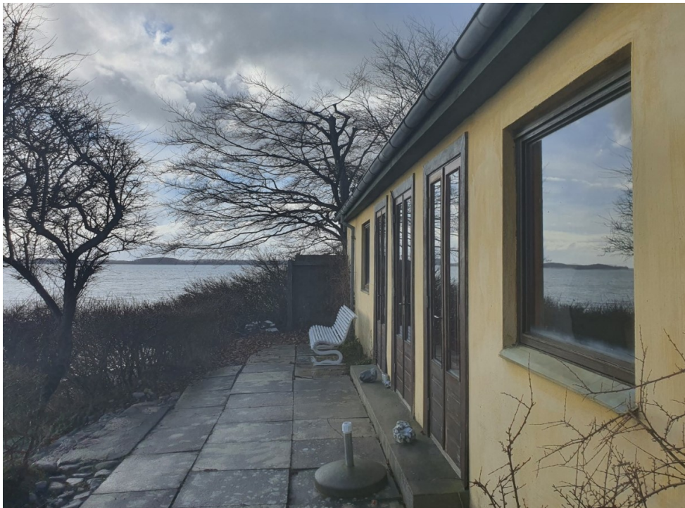
Foto af sommerhusets facade mod syd. Indsendt af ansøger.
