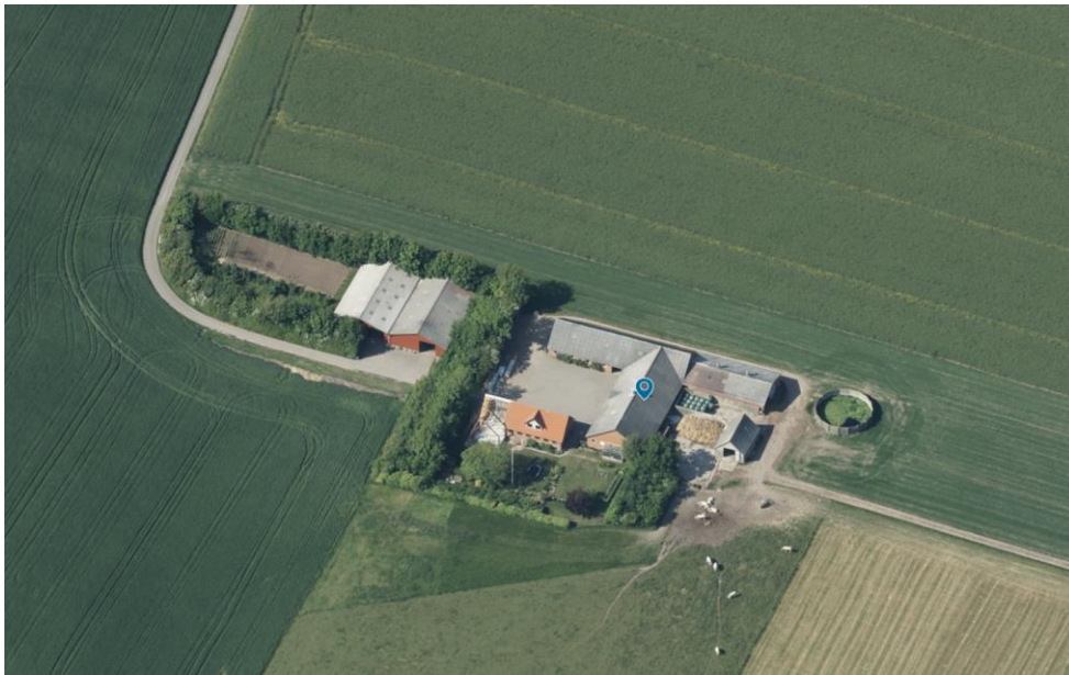
Skråfoto viser ejendommens bygninger
