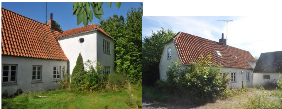
Billeder der viser den eksisterende bebyggelse. Indsendt af ansøger.
