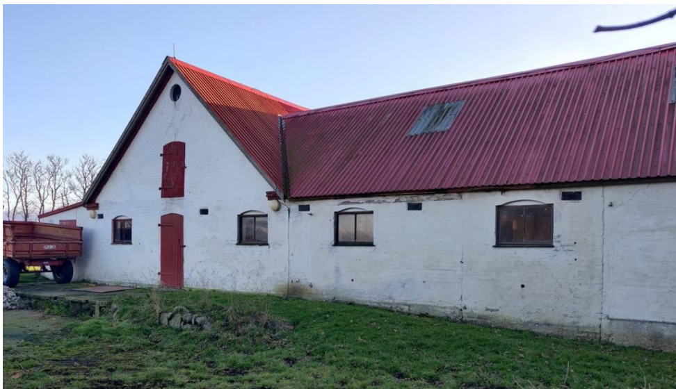
Eksisterende facade mod nord
