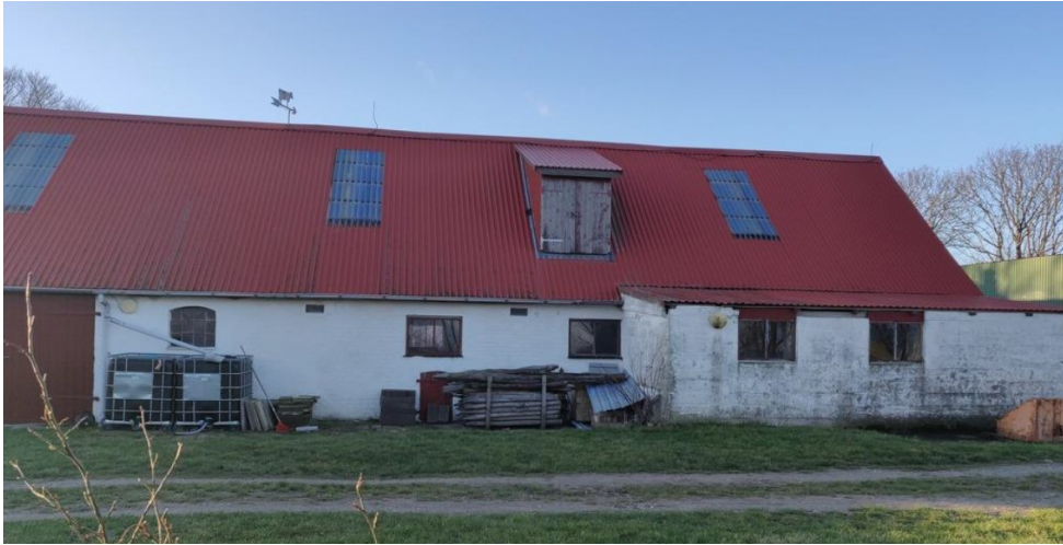
Eksisterende facade mod øst. Tilbygningen forrest til højre nedrives.
