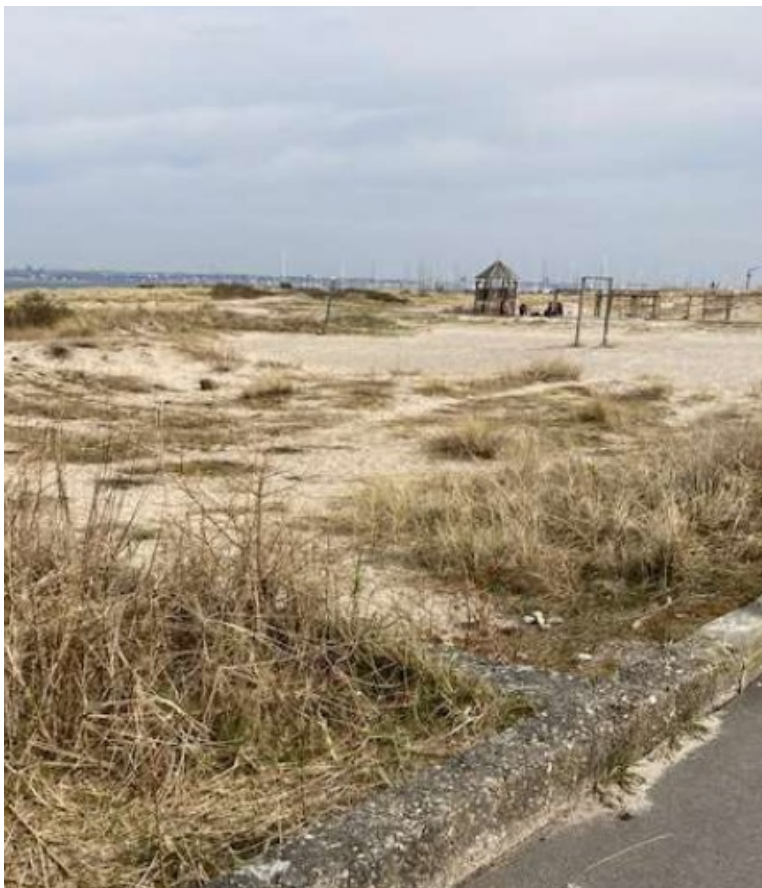
Foto af området. Den nye bane lægges i forgrunden af billedet, hvor der fjernes bevoksning. I baggrunden ses eksisterende baner og legeplads. Længst bagude anes havnen.
