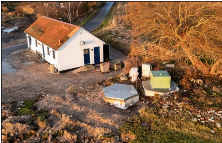
Foto af den eksisterende sugebrønd med nyt betondæk med 2-delt topskab.
