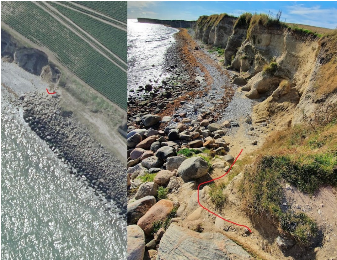
Fig. 3. Skråfoto med oversigt til venstre, udsigt mod syd til højre. Røde streger viser trampestiens placering. Øverst til højre ses forspringet i klinten, der begrænser adgangen til strandafsnittet sydfra (fra ansøgningen).
