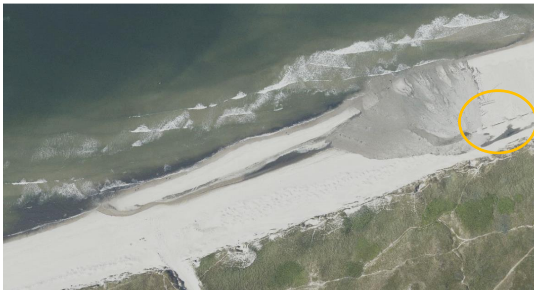
Figur 6-36. Strandfodring med rørledning ved Årgab 86 . Rørledningen er markeret med orange cirkel.
