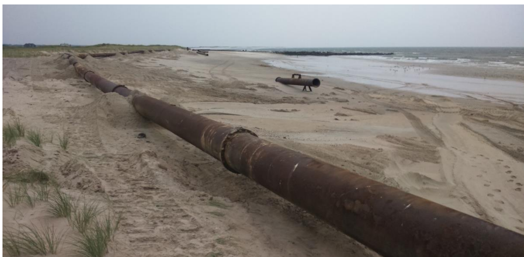
Figur 3-8. Indpumpning med bundliggende rørledning ved Blåvand.
