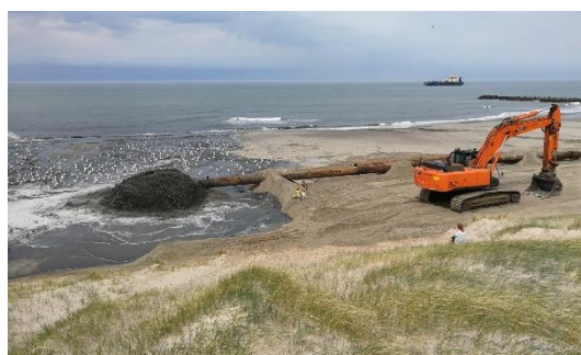
Figur 6-38. Strandfodring med rørledning fra skib ind på stranden. 87
