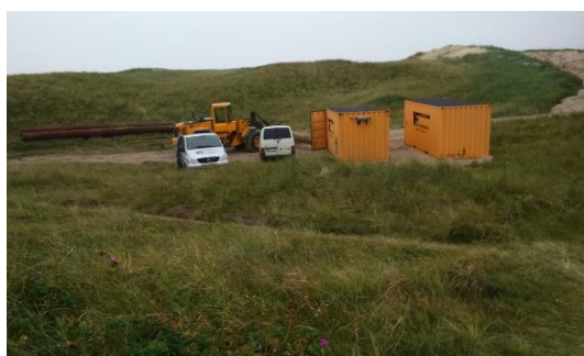
Figur 6-37. Eksempel på arbejdsplads 87 .
