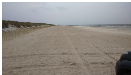
Figur 6-35. Stranden efter det indpumpede sand er udjævnet med en gummied og der er plantet hjælme ved foden af klitrækken.
