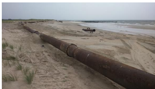
Figur 6-34. Igangværende strandfodring, hvor sandet pumpes ind med rørledning.
