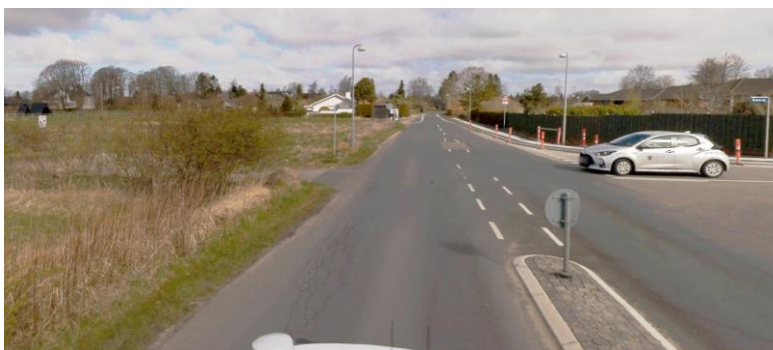
Eksisterende forhold set fra syd
