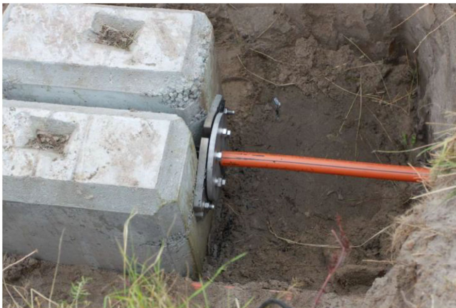
Figur 11 – Søkabel monteret i betonankerblok i land.
