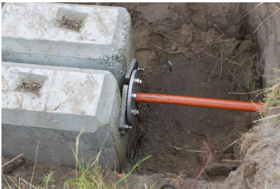
Figur 6 – Søkabel monteret i betonankerblok i land.
