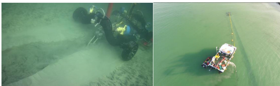
Figur 7 – Af figuren ses XLJET i færd med spuling på projektet Skagenfiber. Som det ses, er sedimentspredningen minimal.
