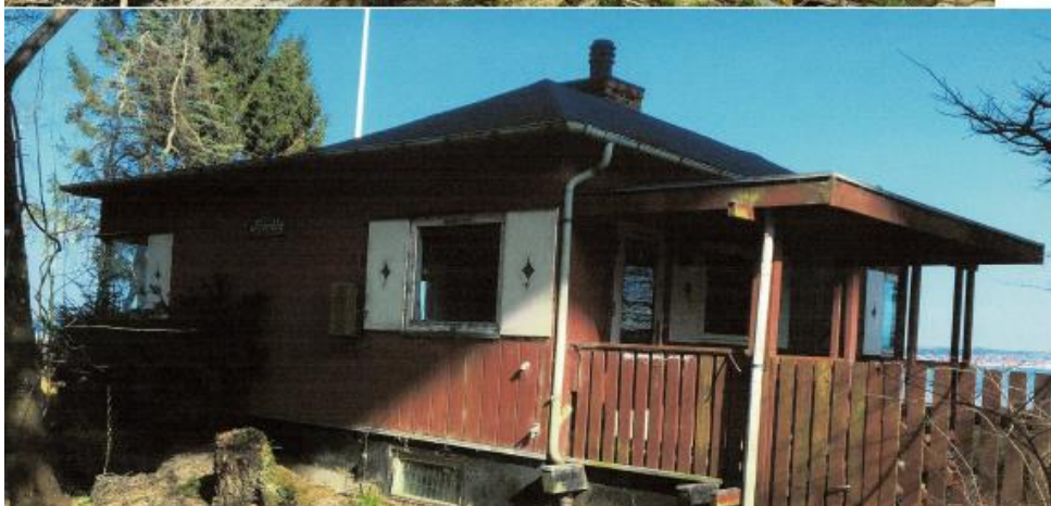
Figur 2: Billeder af det eksisterende hus
