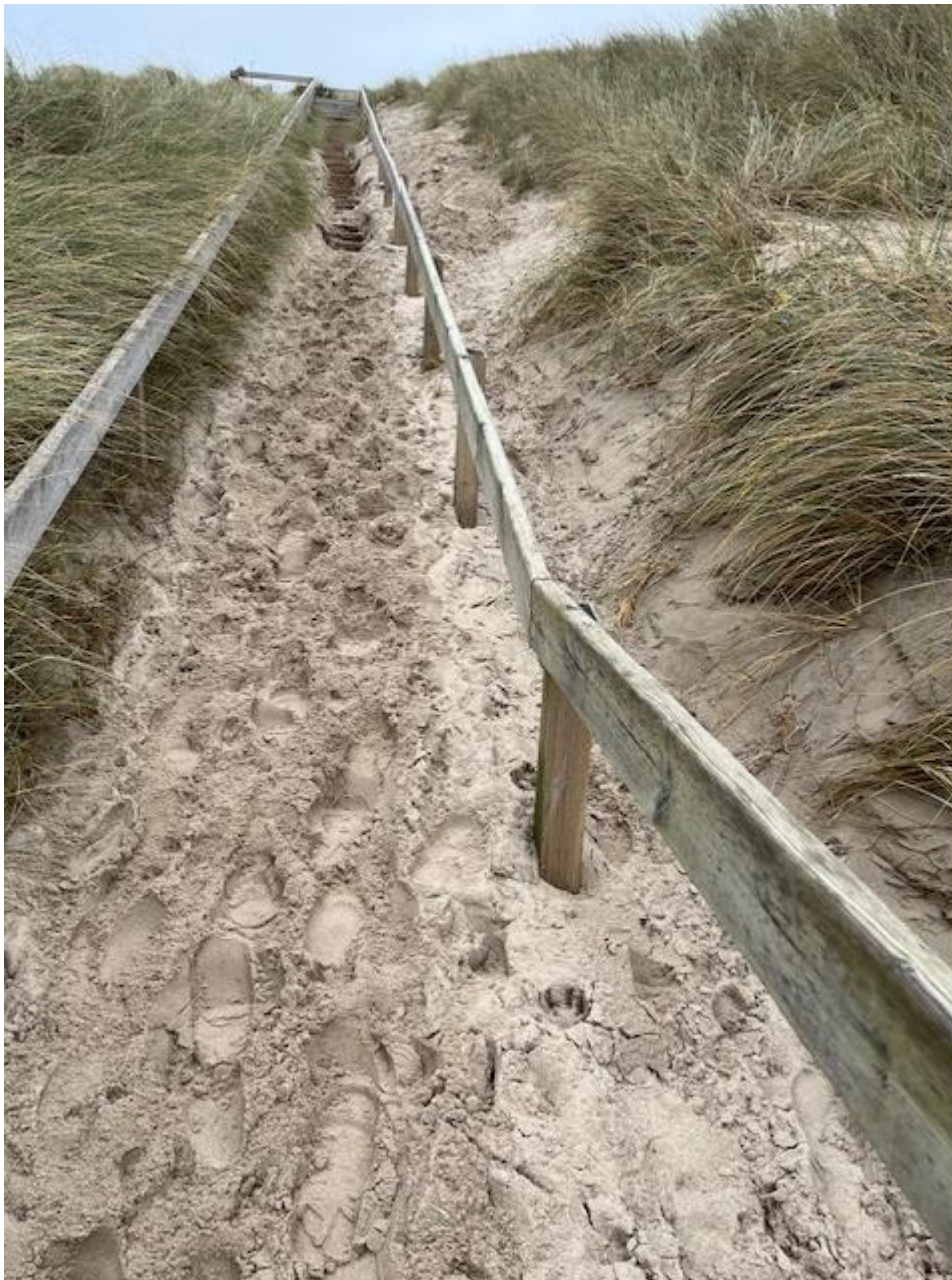
Fra ansøgningsmaterialet. Kraftig tilsanding af den nederste del af trappen.
