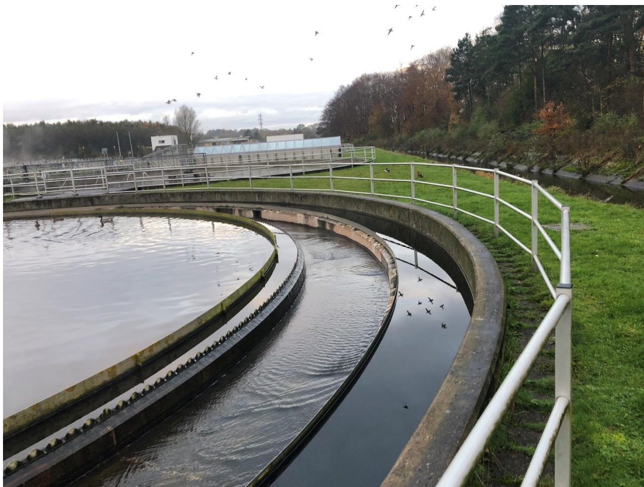
Billede 2: Beliggenhed af bygningsværker tæt ved Døde Å. Foto taget mod nordvest fra efterklaringstank (bygning nr. 8) mod filterbygning (bygning nr. 19).
