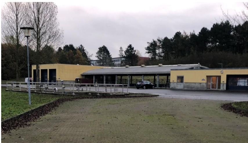
Bygning 1 – Biosorptionstank i forgrunden (Servicebygning (nr. 14) og Forbehandlingsbygning (Nr. 13) i baggrunden.
