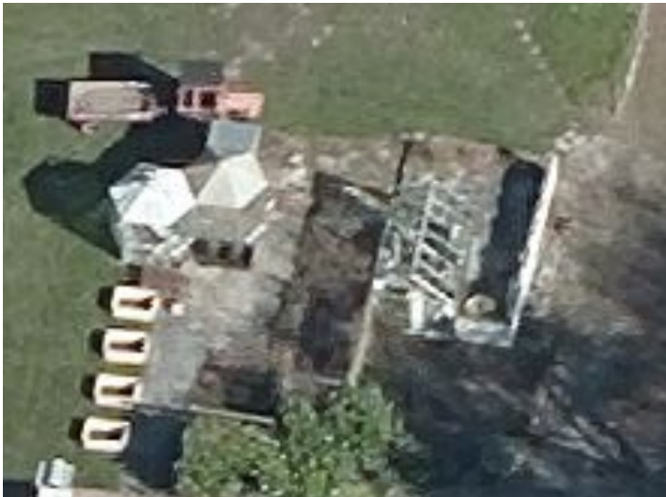
Skråfoto 2017 med drivhus – de to ”glasbygninger” ligger til venstre for drivhus
