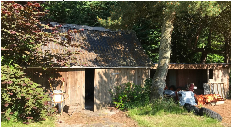
Udhus B3 med overdækning/carport
