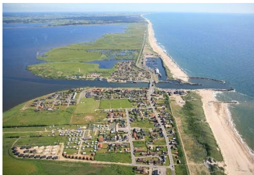
Figur 7-12. Centralt på Thorsminde Tange ligger Thorsminde by. Byen har strukturerede bebyggelsesmønstre langs den gennemgående vej og havnen. Luftfotoet viser desuden den tydelige opdeling af tangen i en strandvoldskyst og ekstensive arealer langs Nissum Fjord 26 . Strandvoldene viser sig på billedet som smalle klitter. Strandvolde dannes ved, at materiale fra havet skyldes op på stranden og løbende danner volde.
