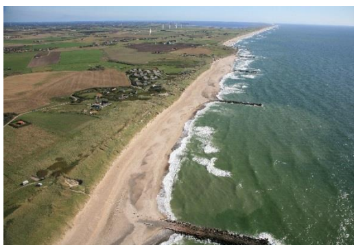
Figur 7-10. Den nordlige del af karakterområde 5 med kyst- og jordbrugslandskab, som er sikret med høfder. Centralt på luftfotoet ses en klynge af bygninger, der er Fjaltring Ferieby 24 .
