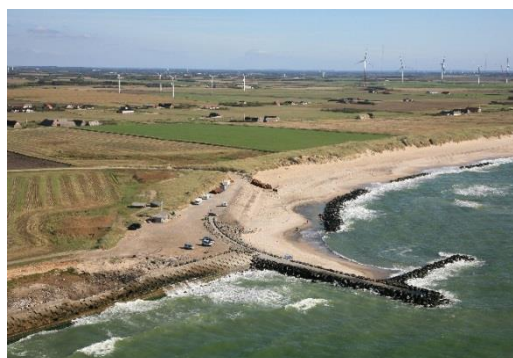
Figur 7-11. Luftfotoets forgrund udgøres af høfde Q. Til venstre for høfden ses skråningsbeskyttelse, mens til højre ses bølgebrydere langs det lave, smalle klitlandskab. Bagved klitlandskabet ses det træløse jordbrugslandskab på en bakkeø 25 .
