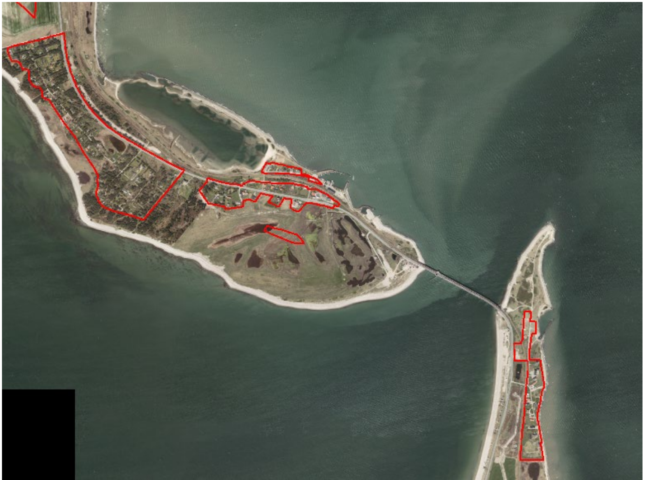
Figur 2. Luftfoto 2017 viser Odde Sund Havn midt i billedet ved den nordvendte kyst. Strandbeskyttelseslinjen er markeret med rød.
