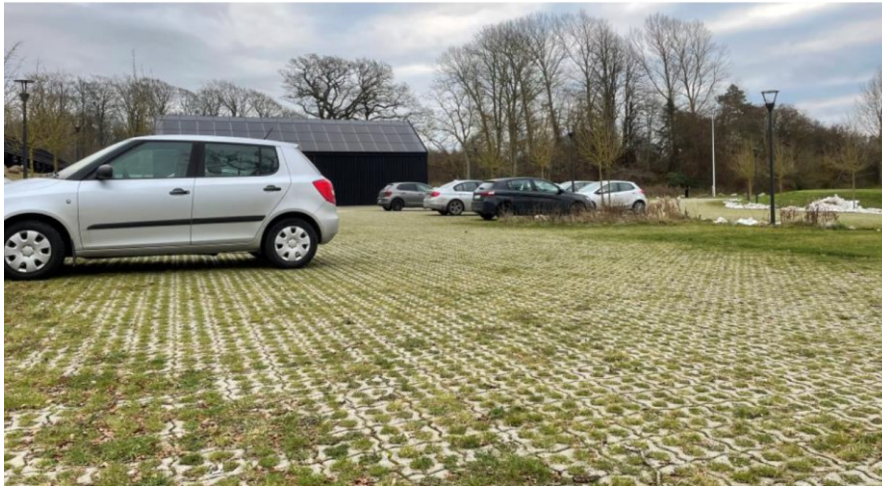
Udvidelsens overflade med græsarmeringssten
