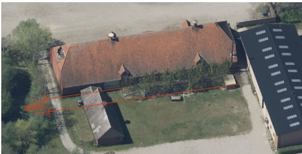
Foto indsendt af ansøger viser den omtrentlige udstrækning af den eksisterende, tilgroede rampe.
