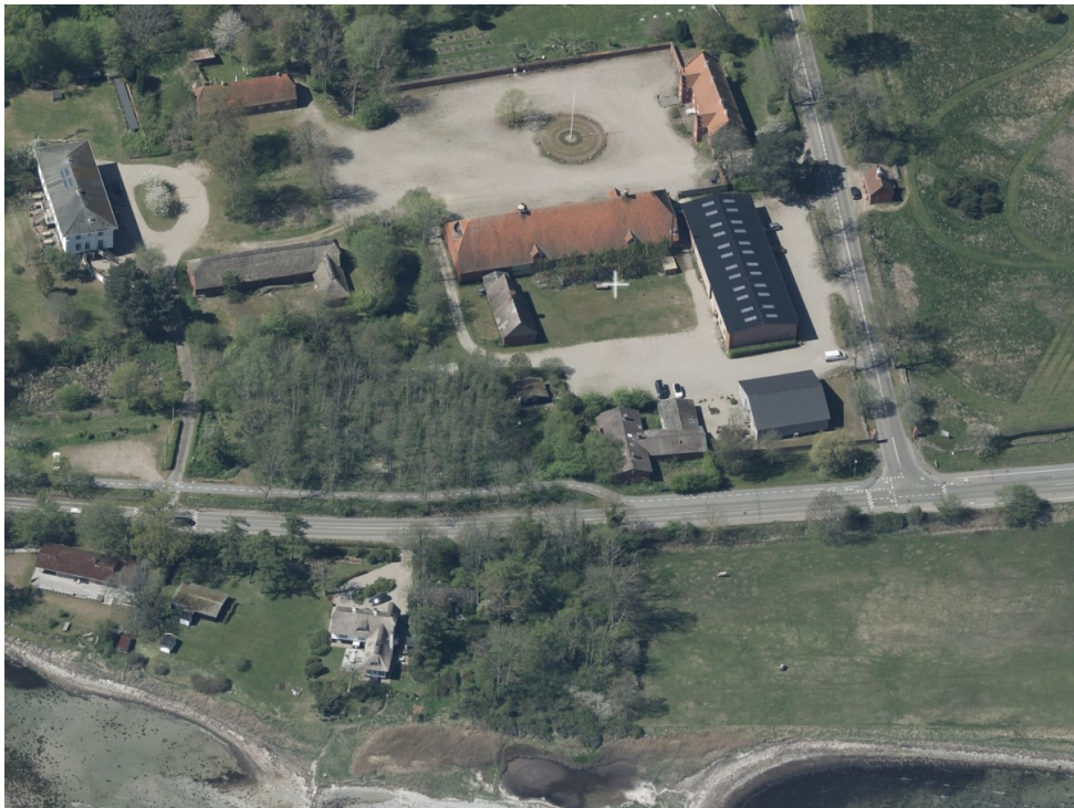
Luftfoto af ejendommen og kystarealerne. Terrasse og trappe anlægges omtrent ved det hvide kryds.
