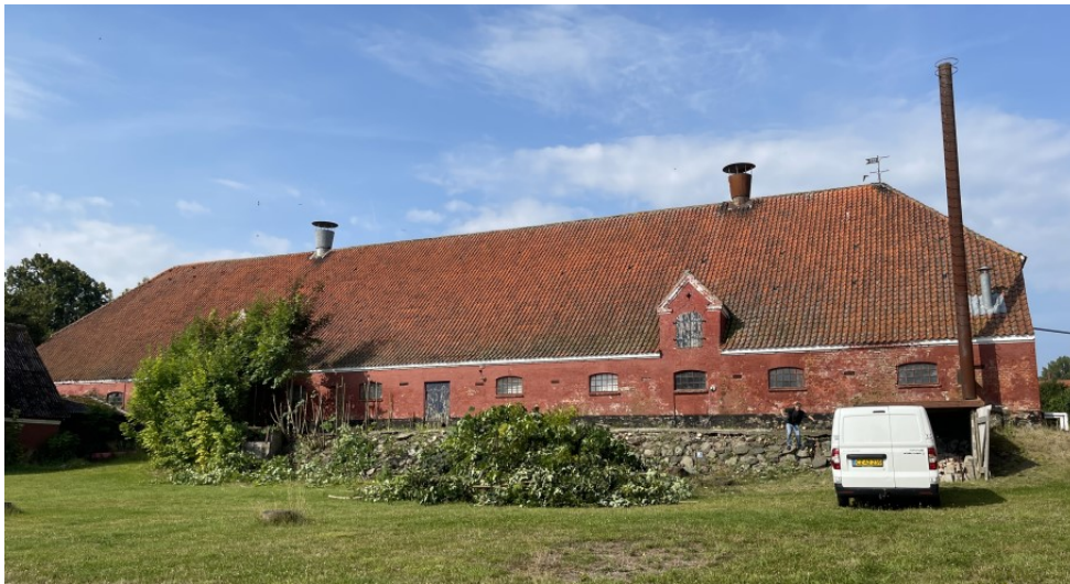
Foto af eksisterende forhold efter delvis rydning af bevoksningen på rampen.
