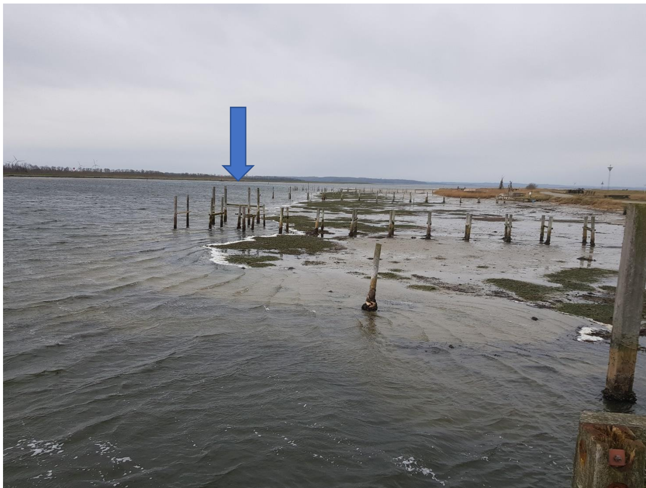
Bådliftens nedrammede træpæle set fra betonmolen mod øst.
