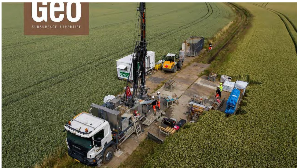
Arbejdsområde med køreplader inkl. borerig, udstyr, Vandtank og manskabsvogn.
