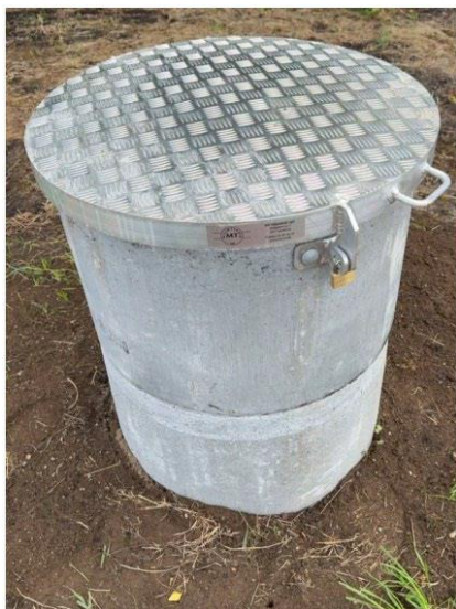
Afslutning med brønd.
