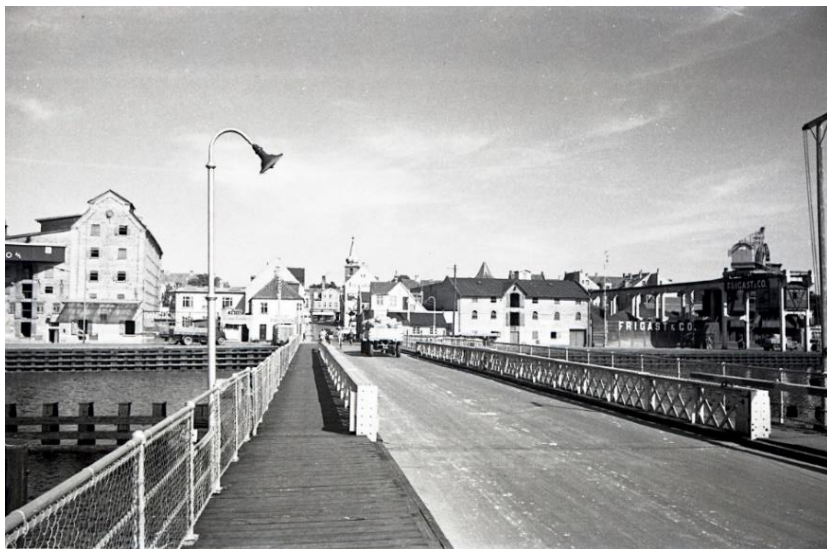
Billedet er taget af svingbroen efter 1933. Kørebanen blev udvidet og der blev placeret ophøjede fortove på hver side af det inderste rækværk. Det yderste rækværk blev trukket ud sammen med fortovet. Kilde: Falsters Egnshistoriske Arkiv. 057-1991_023. Fotograf J. F. Jessen.
